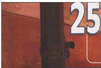
In cazul fixarii burlanelor pe un perete de lemn se va folosi conectorul pentru lemn pentru a se asigura o fixare corespunzatoare a colierelor.
