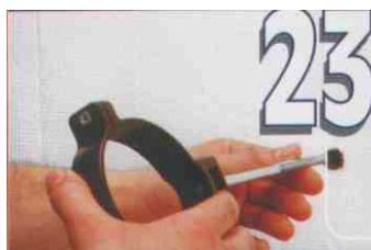
Fixarea burlanelor se face cu ajutorul colierelor de burlan din material plastic si a diblurilor cu holtsurub.
