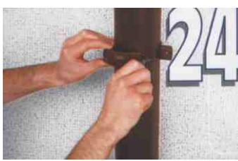
Distanta intre colierele de fixare pentru burlane nu trebuie sa fie mai mare de 2 metri, indiferent daca acestea sunt din material plastic sau metalice.
